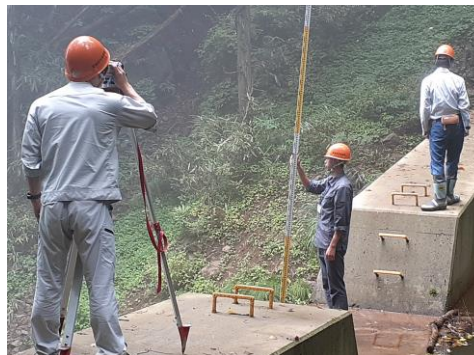
治山工事の検査実習
