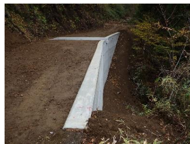
林道改良（災害復旧）
