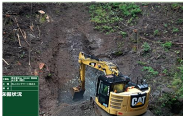
MGバックホウによる施工
