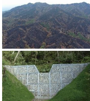
林野火災跡地と谷止工
