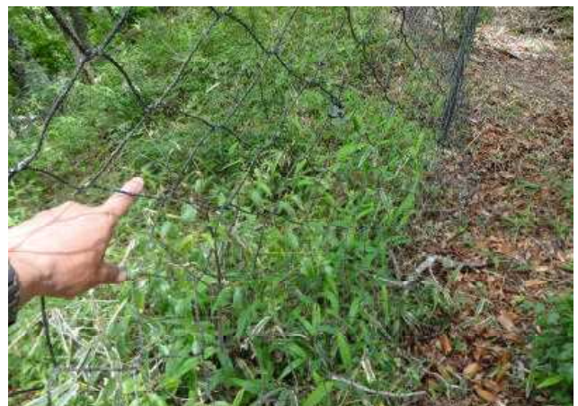
シカ防護ネット柵点検の様子
