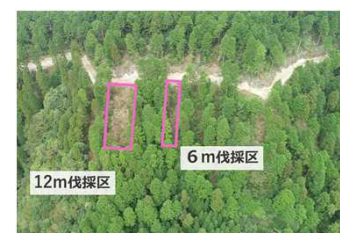
上木伐採後の上空から状況 (幅12mの伐採区と幅6mの伐採区の比較)
