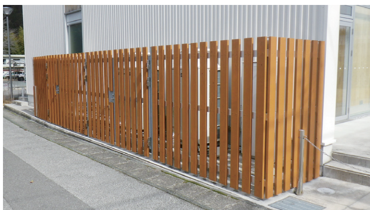
塗布後の木製フェンス
