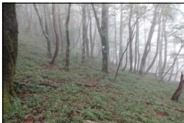
シカ防護ネット柵の設置前（9/18）
