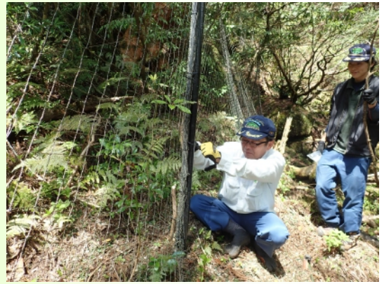
職員によるシカ防護ネットの補修
