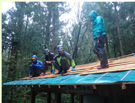
屋根板の張替作業
