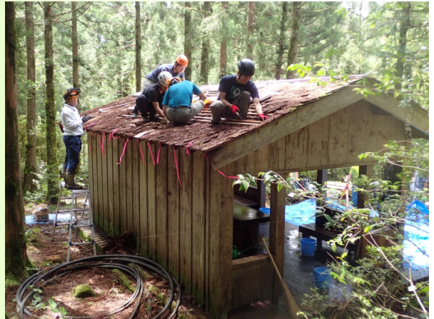
屋久島地杉で屋根補修
