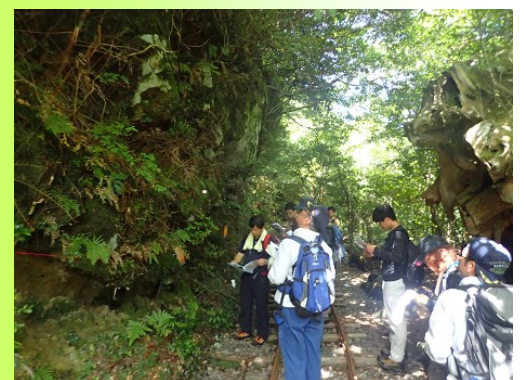
法面に異状が無い点検中
