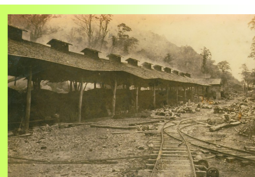
写真2 小杉谷地区に建設された集合釜 (昭和4年)
