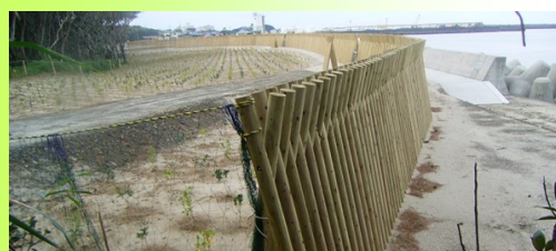
完成した防潮護岸工・植栽工
