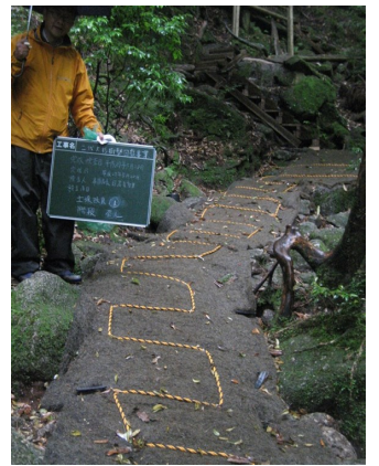
<写真2> 既存歩道
