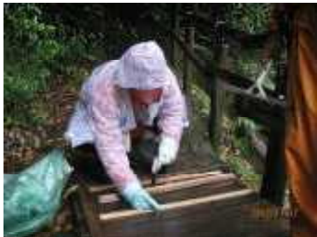
木道の滑り止めの交換
