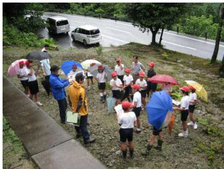
治山工事施工箇所にて。
