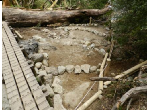
植生保護施設整備の状況
