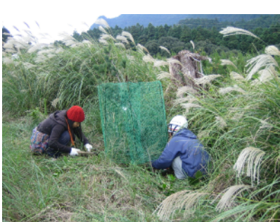
保護柵補修の作業風景
