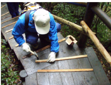
写真は、昨年、白谷雲水峡での歩道整備の状況
