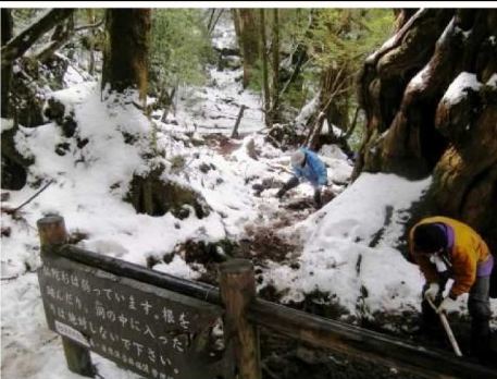
土壌改良工事の施工風景
