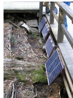
Webカメラソーラーパネル増設
