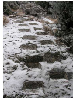
植生等回復措置 (岩切込工)
