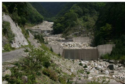
継続した谷止工の設置
