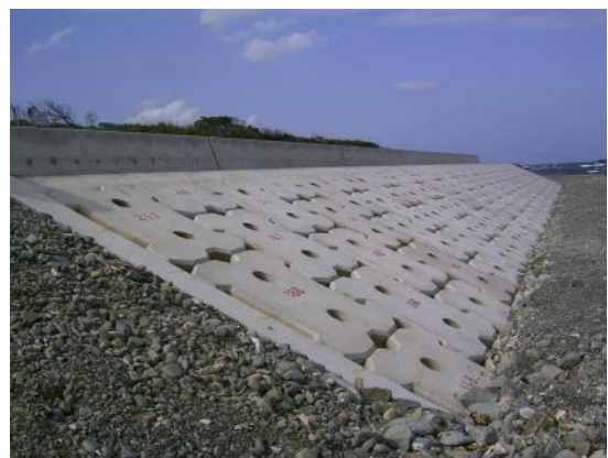
傾斜型護岸工(種子島)
