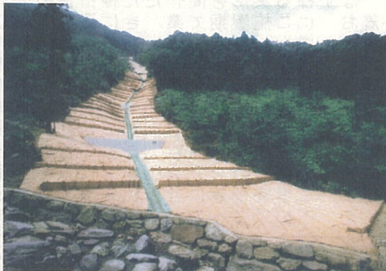
17年度石塚岳治山工事
