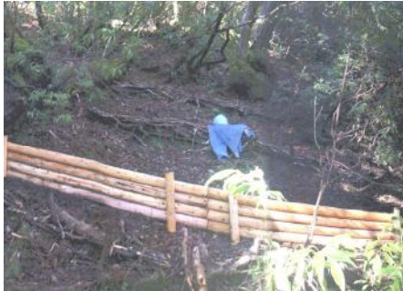
縄文杉樹勢回復措置(丸太筋工・植栽工)実施状況
