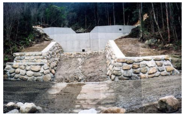
コンクリート谷止工
