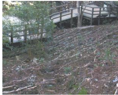
縄文杉樹勢回復措置(丸太筋工・植栽工)実施状況
