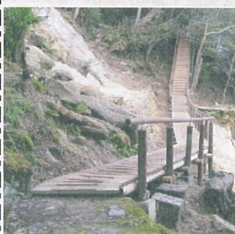
完成した弥生歩道
