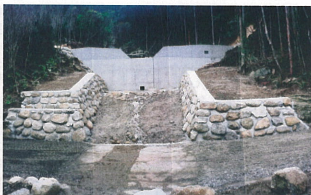
(16年度宮之浦岳治山工事)
