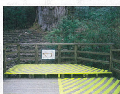
塗り替え後の縄文杉展望デッキ
