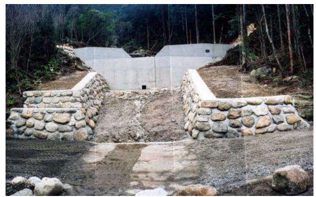
コンクリート谷止工
