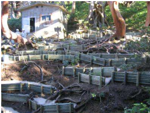
高塚小屋周辺植生回復工事
