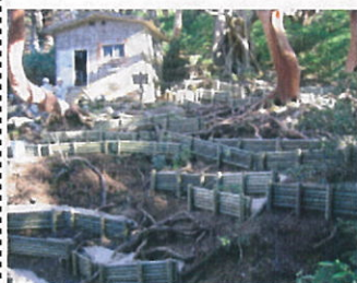
(木柵工実施状況)
