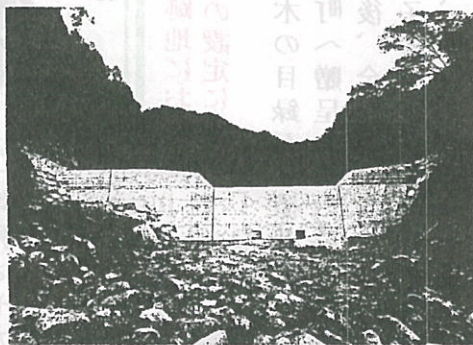
(谷止工実行状況)
