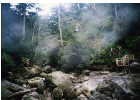
(H14橋脚工事)
