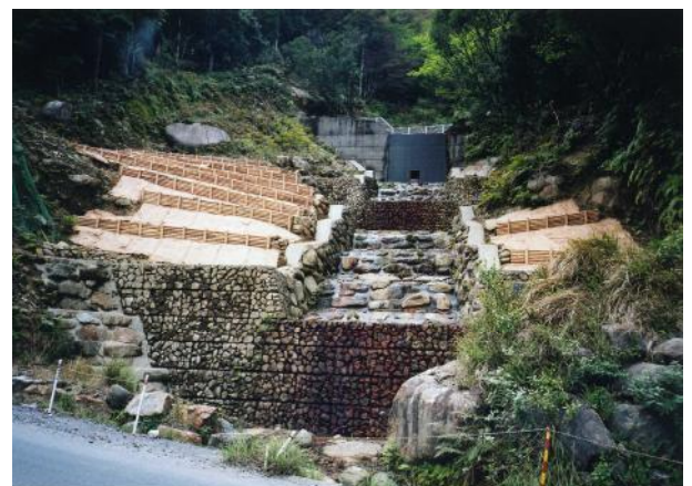
宮之浦岳治山工事(木柵工・路面保護工)
