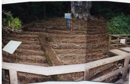
縄文杉樹勢回復措置(編柵工・土壌改良)実施状況
