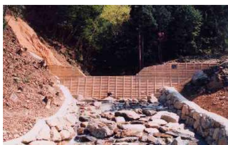
石塚治山工事 (木製型枠谷止工)
