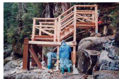
(天柱橋橋脚工事)
