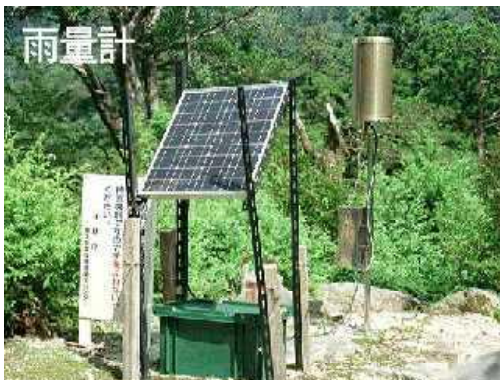
大川林道雨量計(標高1,020m)
