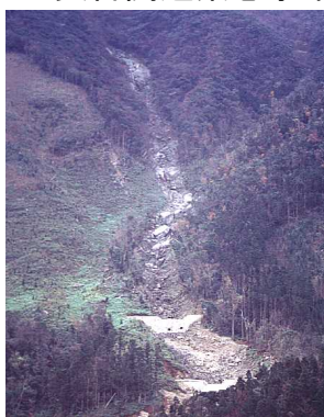
災害復旧実施状況
