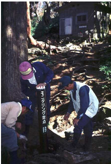
定点杭設置状況
