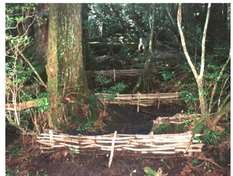
仏陀スギ樹勢回復措置（編柵工）実施状況
