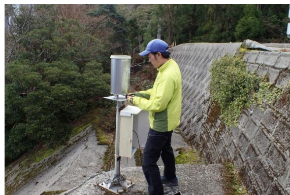
職員による雨量計（転倒マス）の清掃
