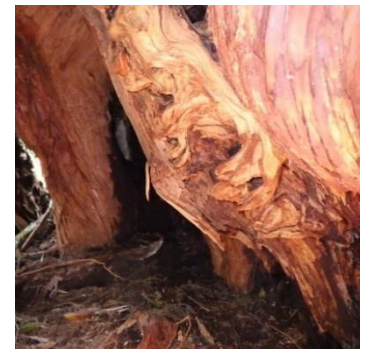
(妻)根元空洞内部（南側から撮影）
