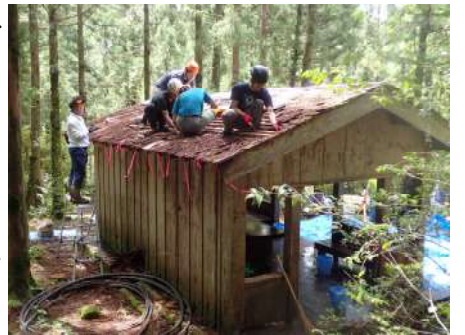
屋久島地杉で屋根を補修
