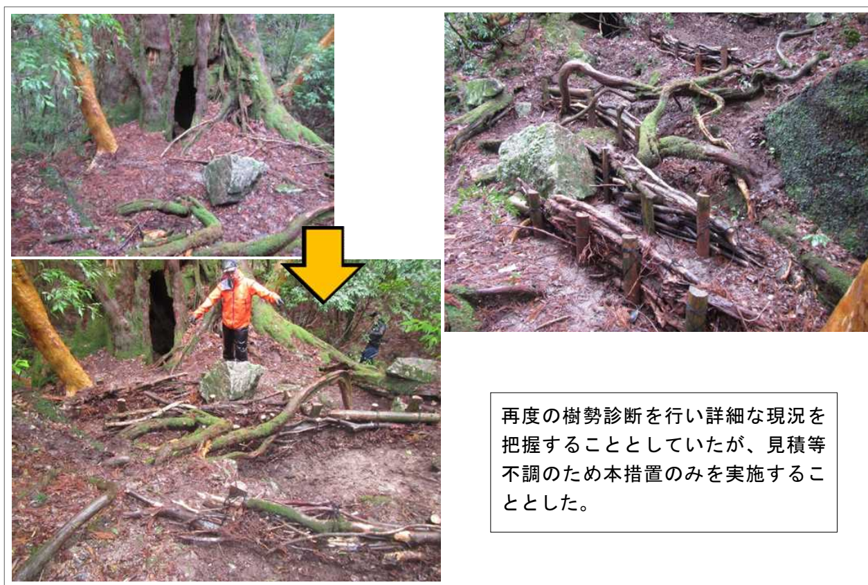
図2-1. 編柵工設置の前後
