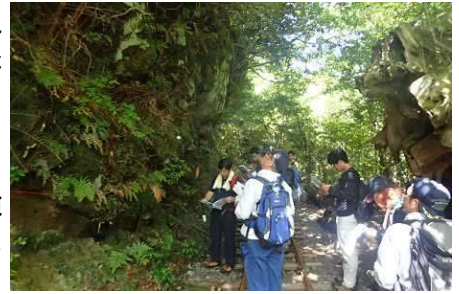
写真1-2. 法面に異状がないか点検
