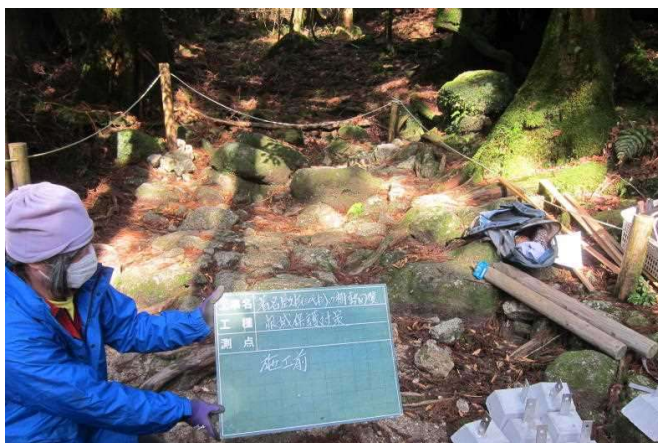
写真2-6. 木製デッキ設置状況
