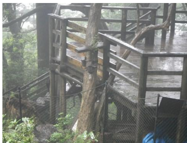
写真(3)-2. 南デッキに設置したセンサーカメラ2台
