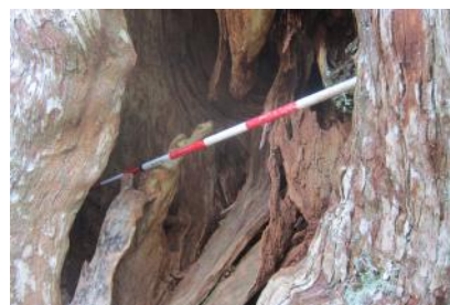
写真(1)-3. 空洞の状況調査
