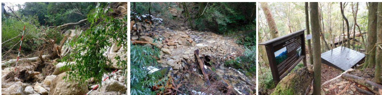
さつき吊り橋付近の崩壊地（左）、崩土除去及び歩道補修整備状況（中）、遊歩道・看板・木製デッキの整備状況（右）
