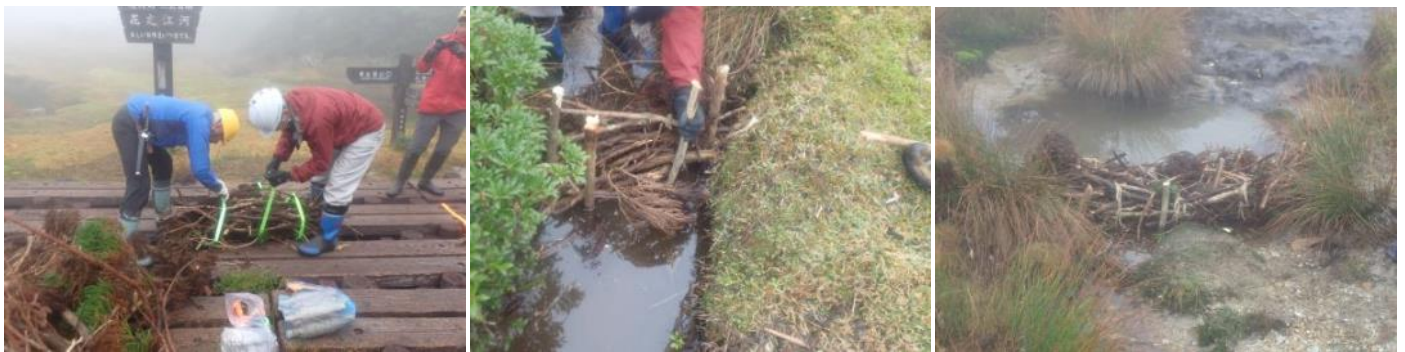
堰の作成（左）、流路に堰を設置（中）、堰の完成（右）
