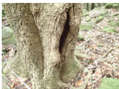
カラスザンショウ大径木の 損傷した根元部分
