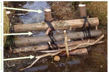
図2 丸太木柵工の形状
