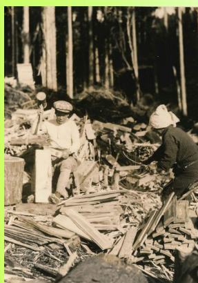
(左)当時の平木作りの様子 (上)平木を葺いた屋根
