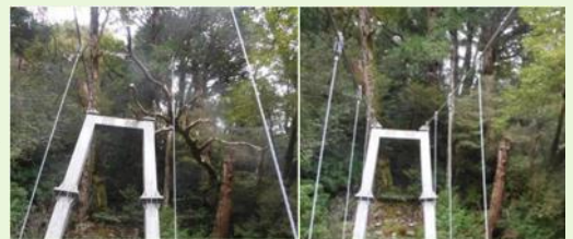
ヤクスギランド沢津橋塔柱のかかり木 （左:処理前 右:処理後）
