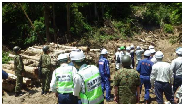
出水期前の関係機関合同緊急点検
