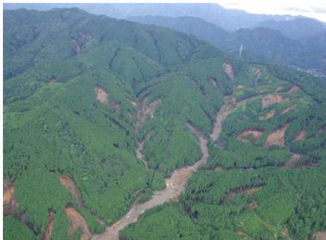
山腹崩壊の状況（妙見川流域）
