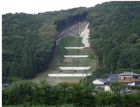
視察先 復旧事業完了後写真(令和5年9月撮影)
