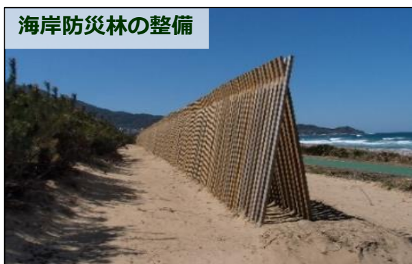
津波の減勢や塩害・飛砂等の軽減のため、海岸防災林の整備を進めています。（岡垣町：福岡署）
