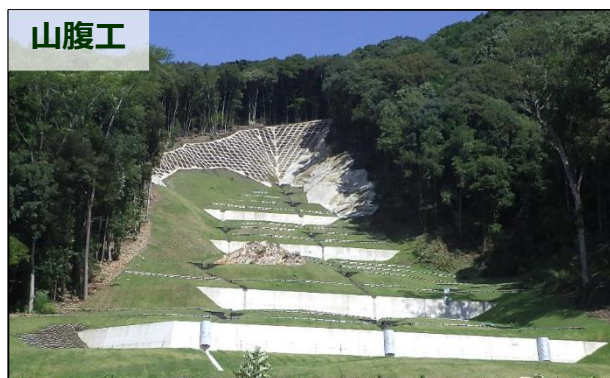
土砂の移動を抑え、植栽した樹木がしっかりと根を張れるよう、崩壊した斜面の安定を図ります。（芦北町：局）
