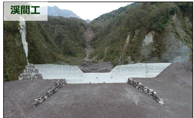
治山ダムを設置し、下流への土砂流出を抑止・調整するとともに、林地の安定性を高めます。(島原市：長崎署)
