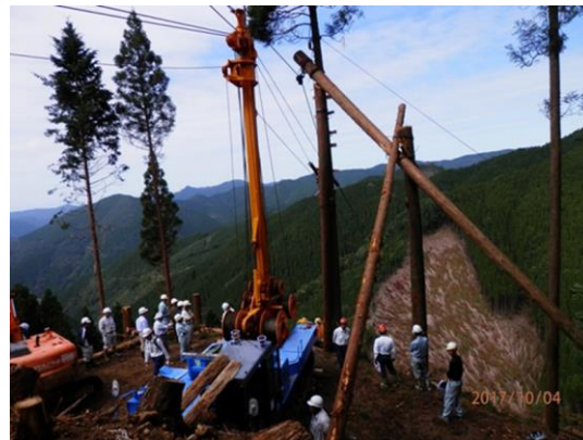
タワーヤードの設置状況
