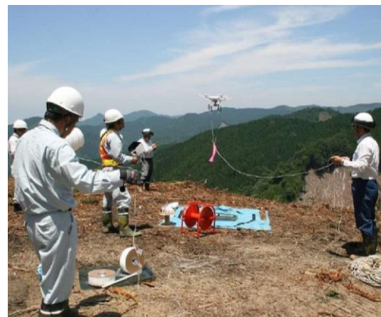
無人航空機による索張りの様子
