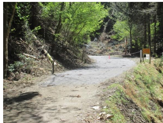
施工直後(平成30年3月)
