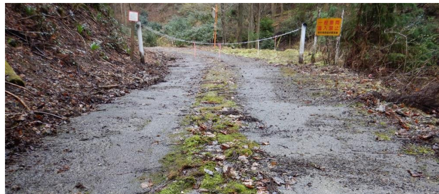
施工後5年(令和5年3月)
