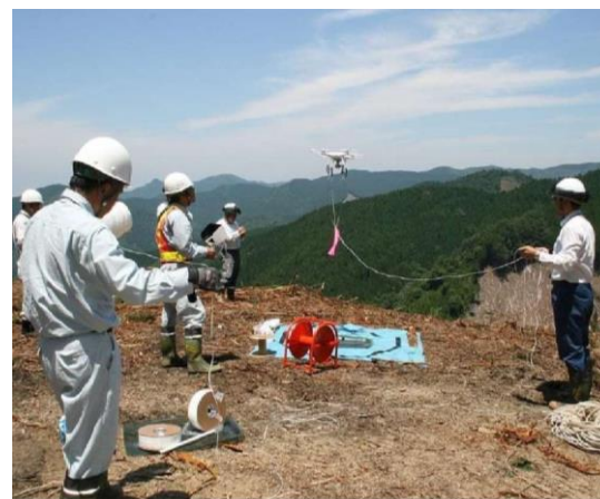
無人航空機による索張りの様子
