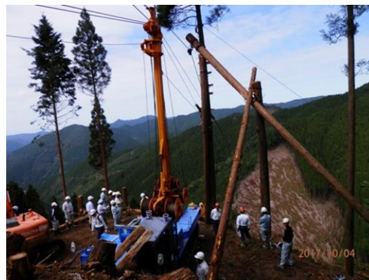
タワーヤードの設置状況
