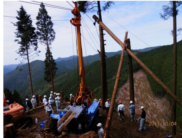
タワーヤードの設置状況
