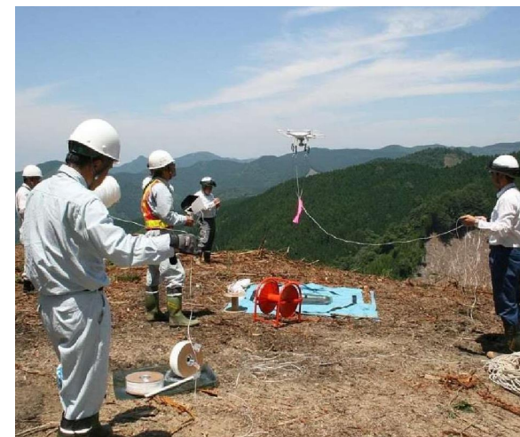
無人航空機による索張りの様子
