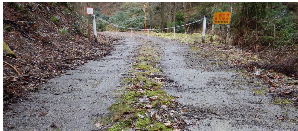
施工後5年(令和5年3月)
