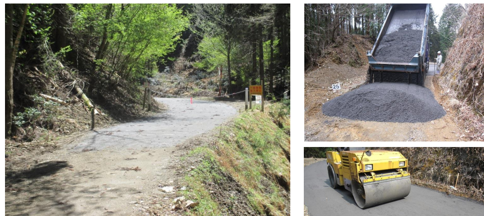
施工直後(平成30年3月)
